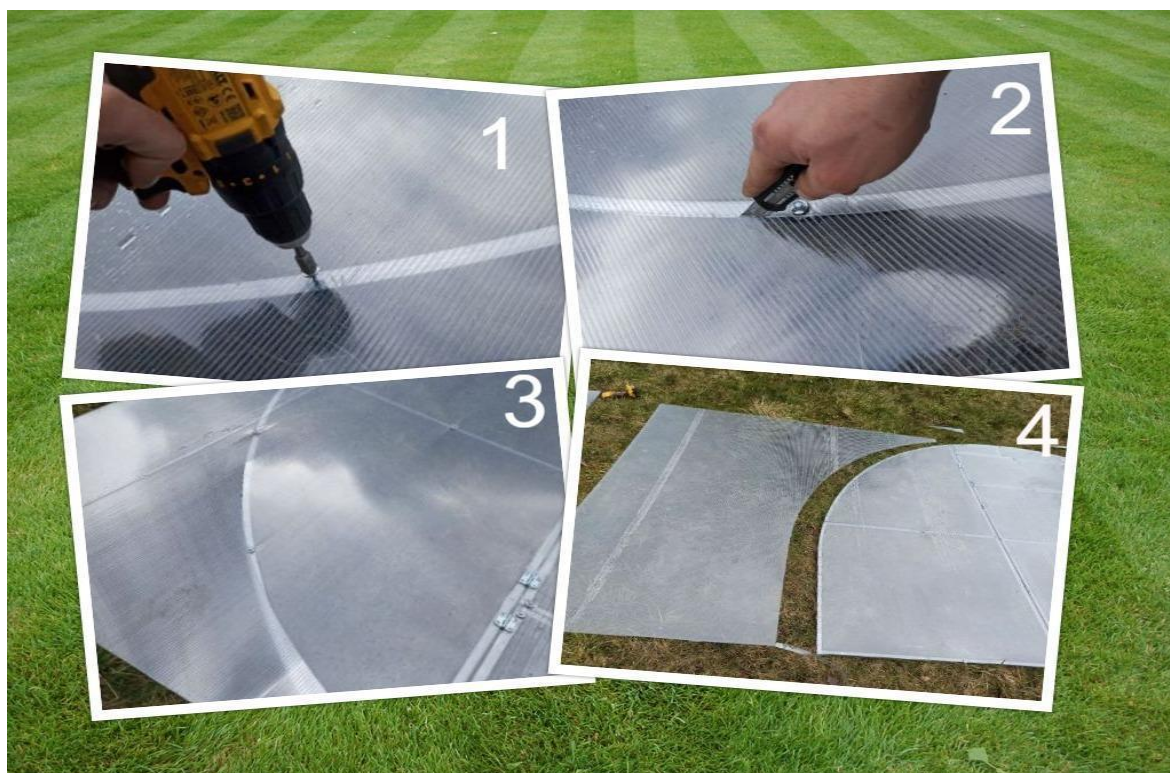
Rysunek 2. Schemat cięcia poliwęglanu
