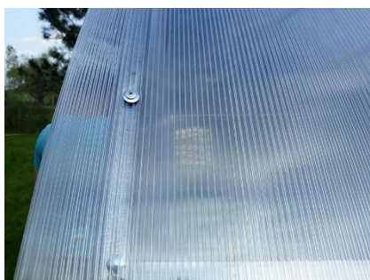
Rysunek 7 – sposób układania pierwszego arkusza startowego na ramę („daszek” 5-6cm)
